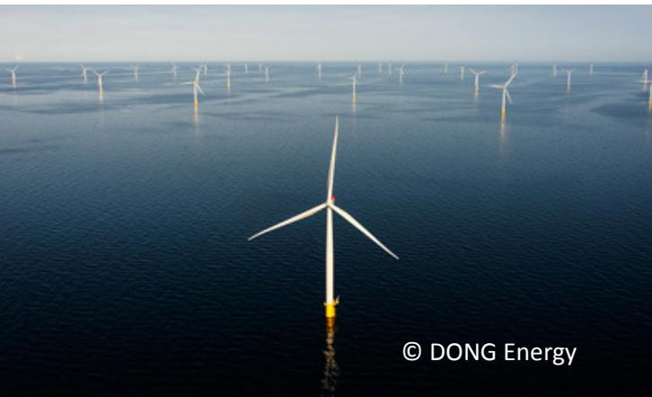
Der größte Windkraftpark Dänemarks steht zwischen Djursland und der Insel Anholt. Die offizielle Bauphase erstreckte sich von Januar 2012 bis September 2013. 111 Anlagen mit einem Rotordurchmesser von 120 Metern und jeweils 3,6 MW Kapazität versorgen rund 400.000 dänische Haushalte mit Strom.
